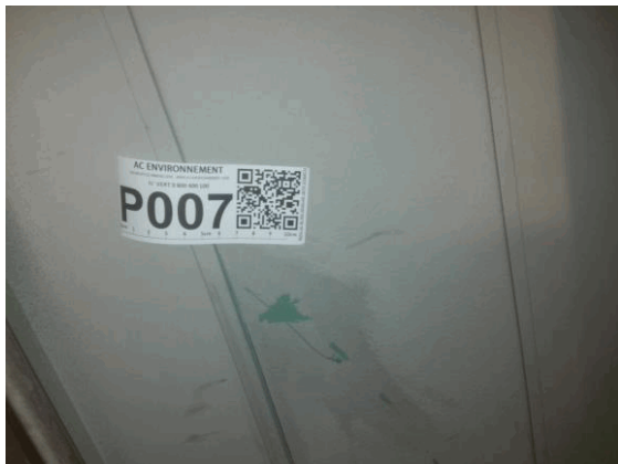
002SB001743-1 n°7 - 1 (P7) - Cabines d'ascenseur - Vol 5 (Cabine d'ascenseur 1)
