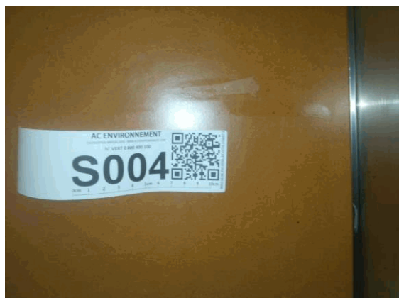
S4 - 1 (S4) - Cabines d'ascenseur - Vol 6 (Cabine d'ascenseur 2)
