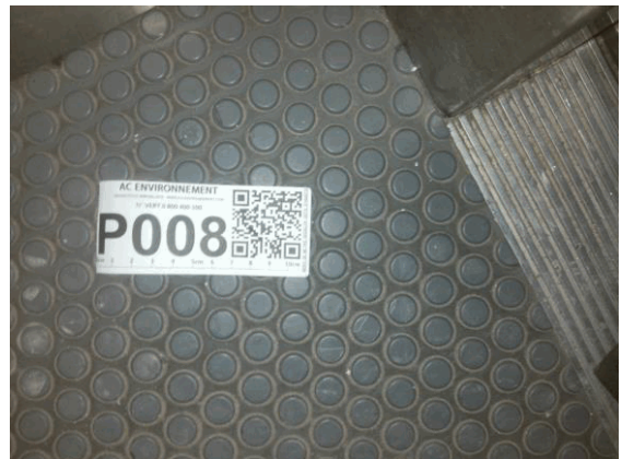
002SB001743-1 n°8 - 1 (P8) - Cabines d'ascenseur - Vol 6 (Cabine d'ascenseur 2)
