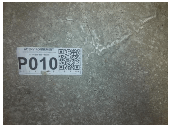
002SB001743-1 n°10 - 1 (P10) - Machinerie - Vol 7 (Machinerie ascenseur)
