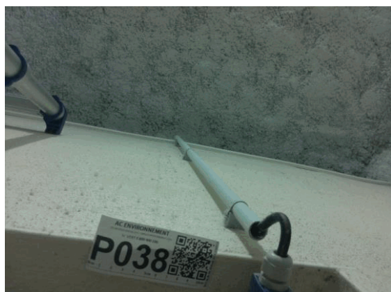
002EX255931-1 n°38 - 1 (P38) - RDC Bat 4 - Vol 26 (Local V.O.)
