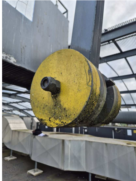
Fig. 4 — Protections caoutchouc arrachées
