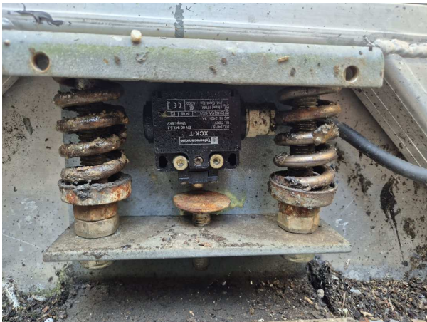
Fig. 5 — Contacts de surcharge oxydés
