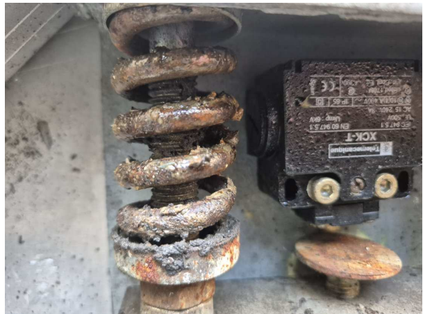
Fig. 6 — Boîtiers de surcharge à reprendre
