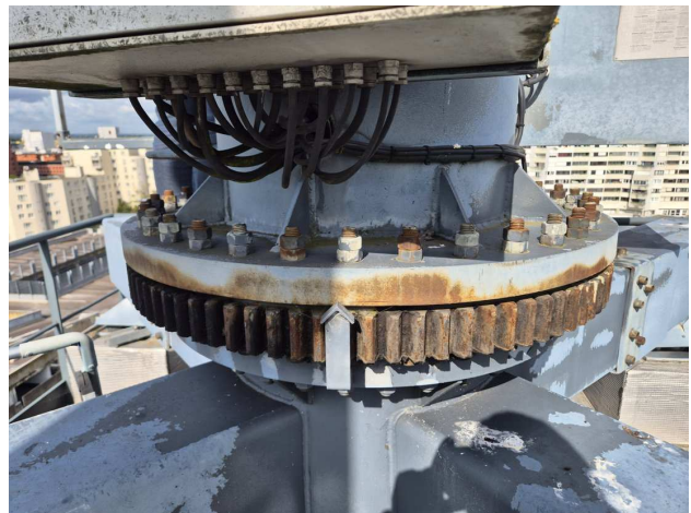
Fig. 20 — Corrosion sur boulonnerie de couronne giratoire
