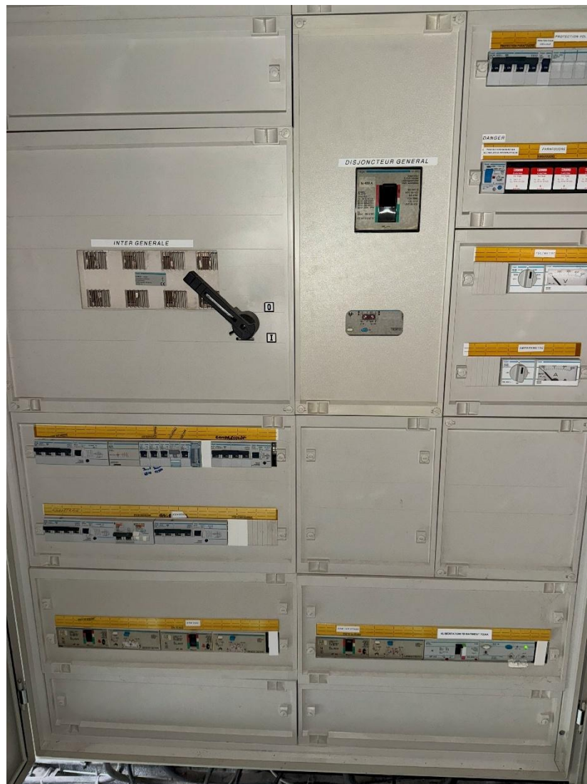
Vue de l'armoire TGBT existant
