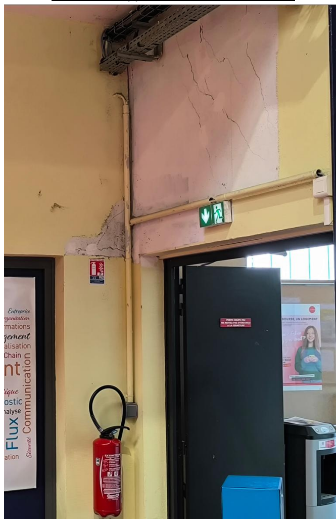
Linteau BA L5 et poutre 2 fissurés – PH RDC
