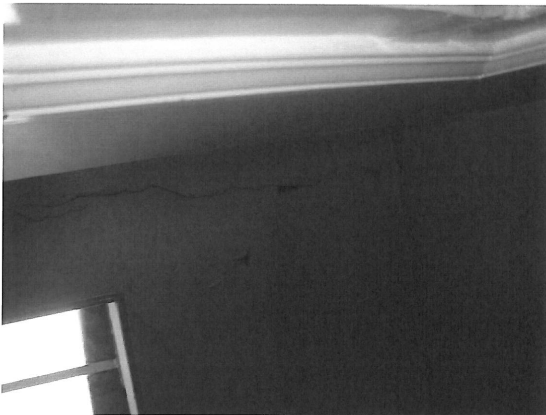
Photo 31 : fissures sur mur porteur de façade ( 2 ème étage)
