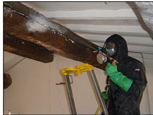
Pulvérisation des bois dans le cadre d'un traitement préventif. Traitement de la surface ainsi que des fissures des poutres.
