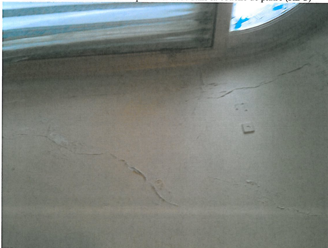
Photo 22 : fissures au niveau plancher haut dans la couche de plâtre (RDC)
