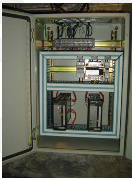
Armoire régulation centrale de traitement d'air
