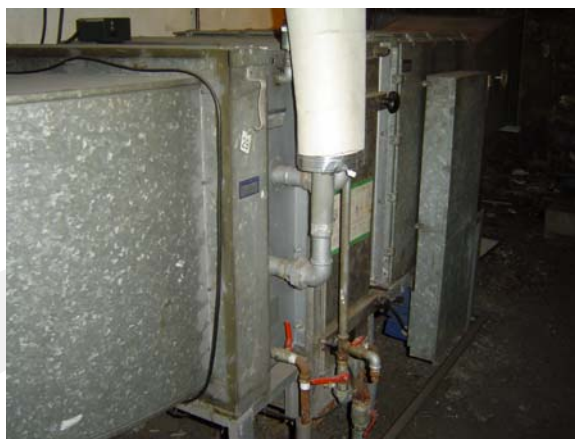
Centrale de traitement d'air du sous-sol
