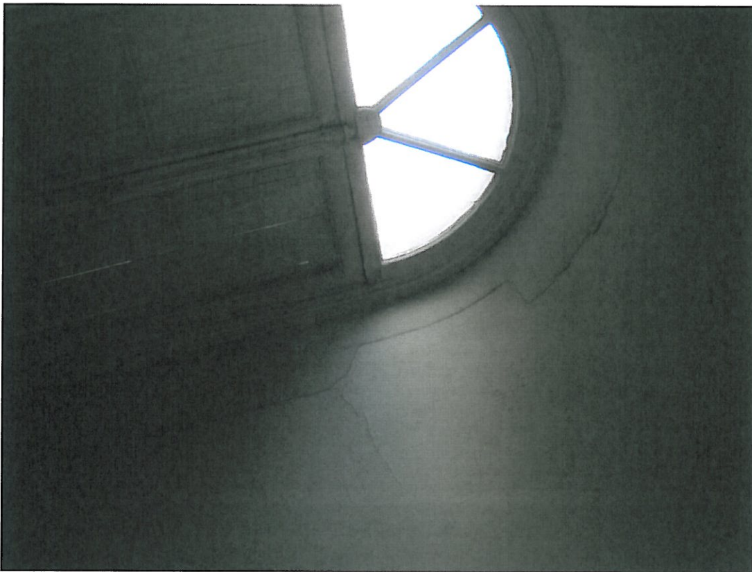
Photo 33 : fissures sur mur porteur de façade et trace de fuite d'eau ( 2 ème étage)
