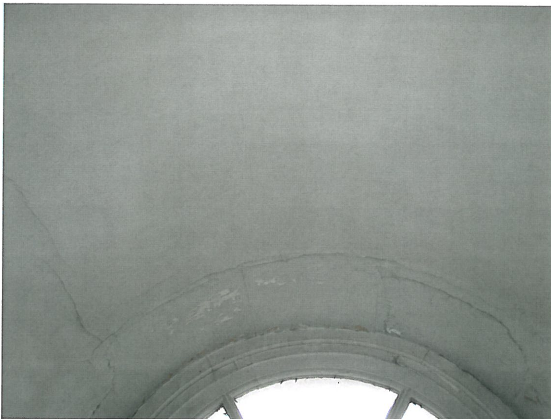
Photo 29 : fissures sur mur porteur de façade et trace de fuite d'eau ( 2 ème étage)
