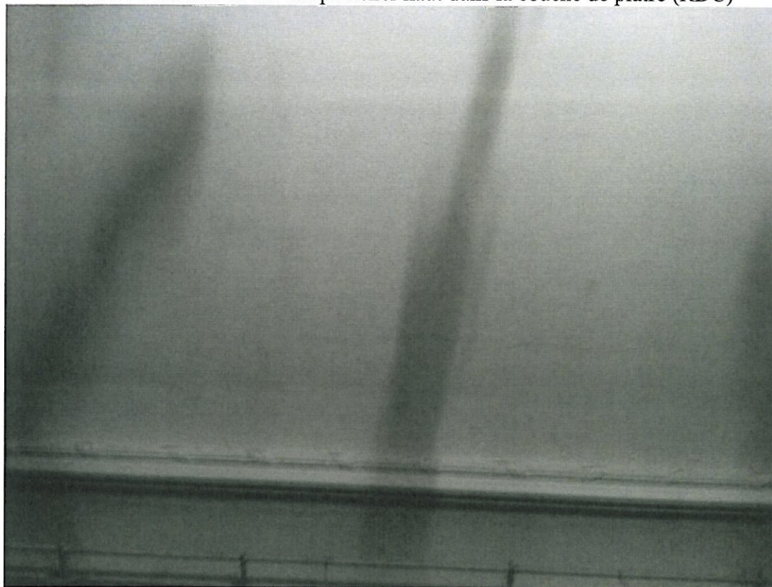
Photo 18 : fissures au niveau plancher haut dans la couche de plâtre (RDC)
