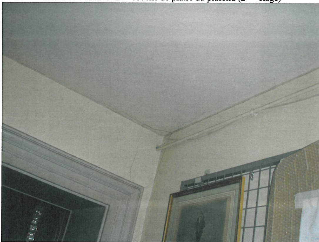
Photo 38 fissure de la cloison (2 ème étage)
