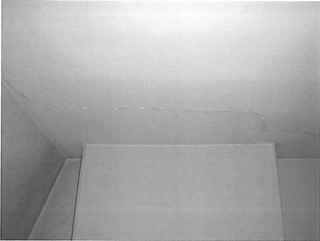
Photo 35 : fissure de la couche de plâtre du plafond (2 ème étage)
