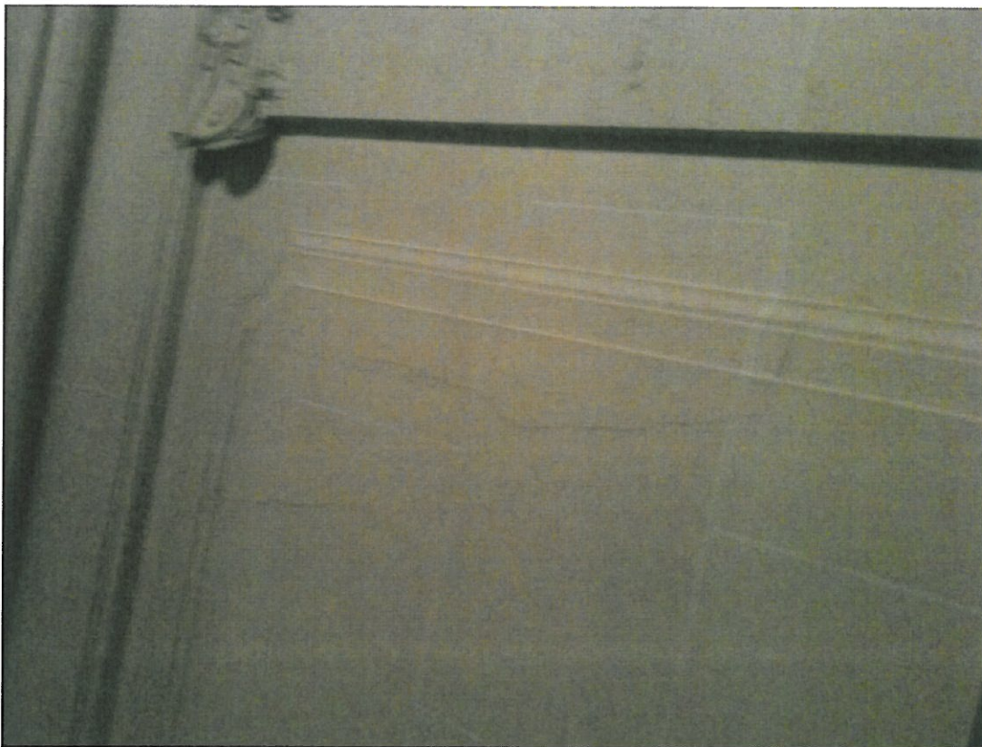
Photo 19 : fissures au niveau plancher haut dans la couche de plâtre (RDC)
