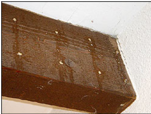
Encastrement percé et injecté d'une poutre, dans le cadre d'un traitement préventif des bois.
