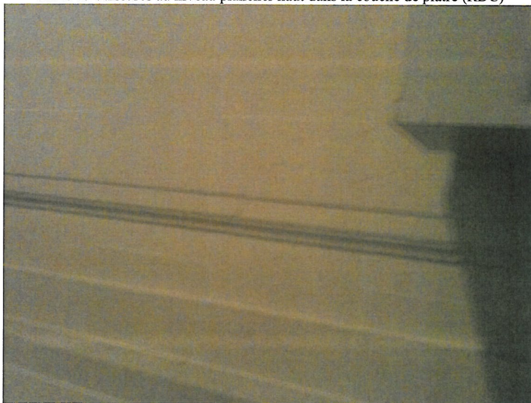
Photo 20 : fissures au niveau plancher haut dans la couche de plâtre (RDC)
