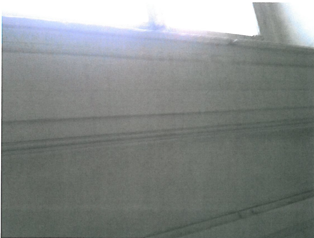
Photo 11 : fissures au niveau plancher haut dans la couche de plâtre cage d'escalier
