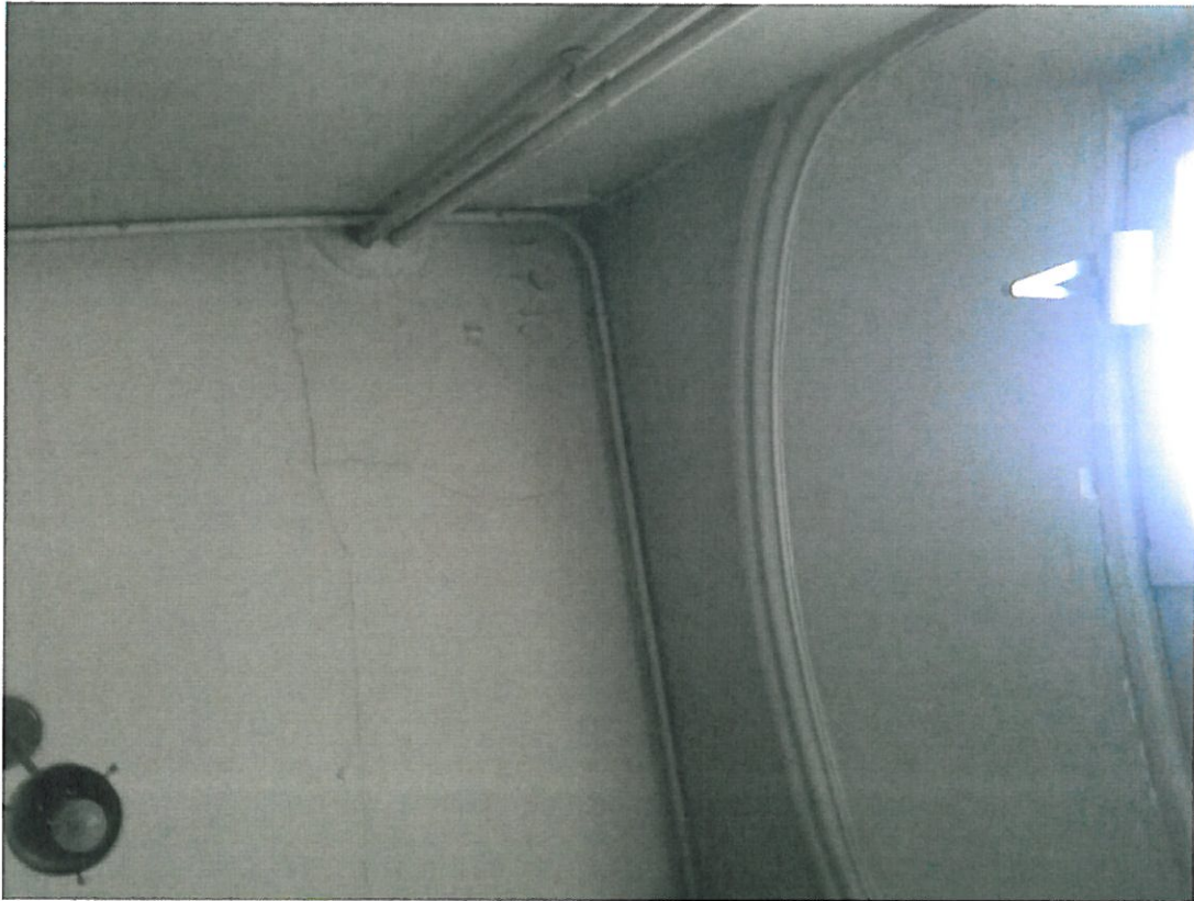
Photo 13 : fissures au niveau plancher haut dans la couche de plâtre (RDC)
