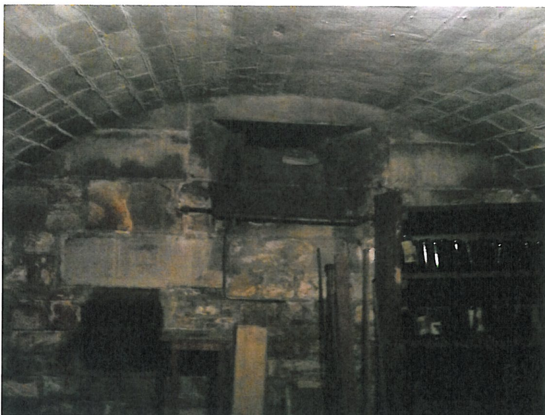
Photo 1 : Trace d'humidité mur de façade (sous sol) + évacuation obturée
