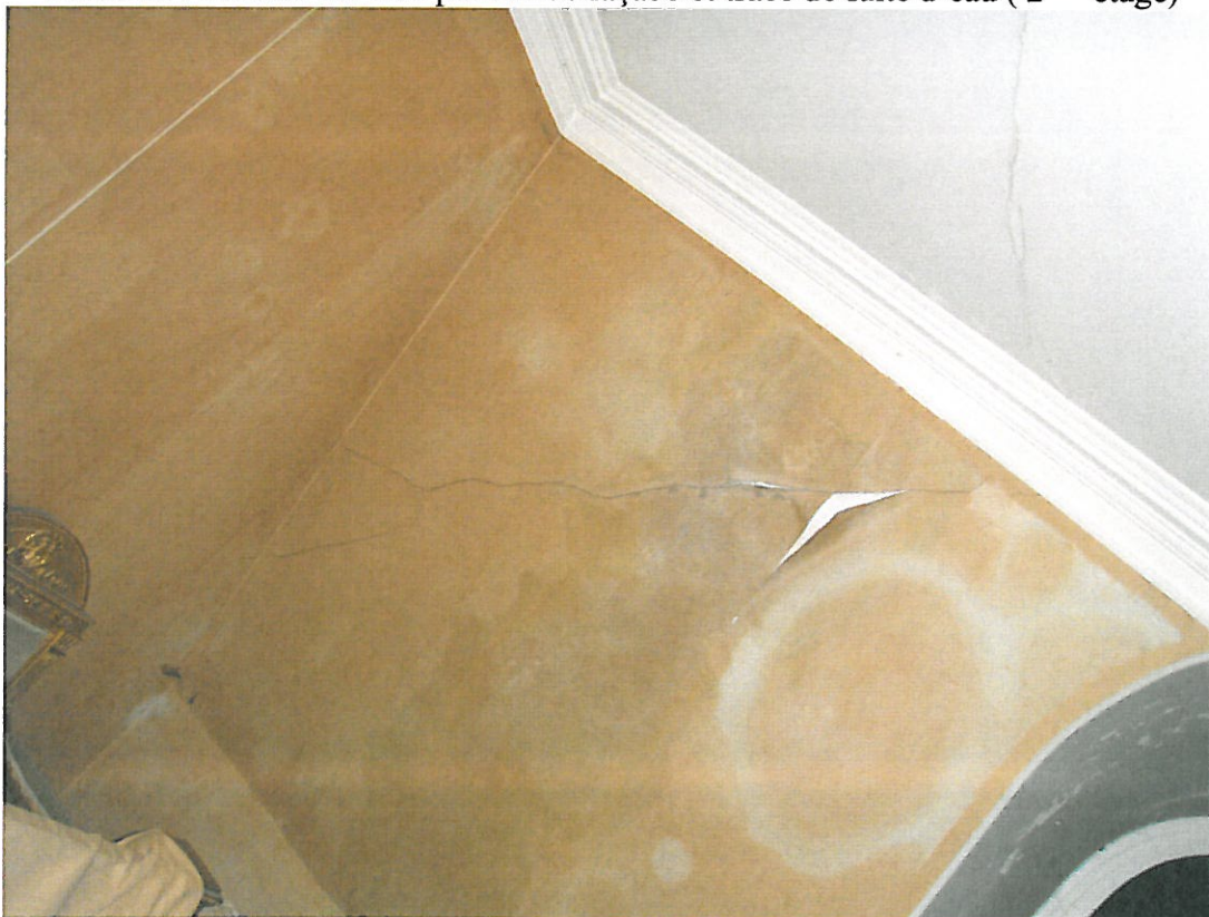
Photo 34 : fissure de la couche de plâtre du plafond et continuité les murs porteurs (2 ème étage)
