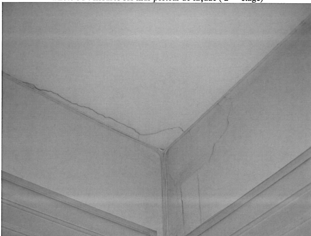
Photo 32 : fissure de la couche de plâtre du plafond et continuité sur la cloison (2 ème étage)
