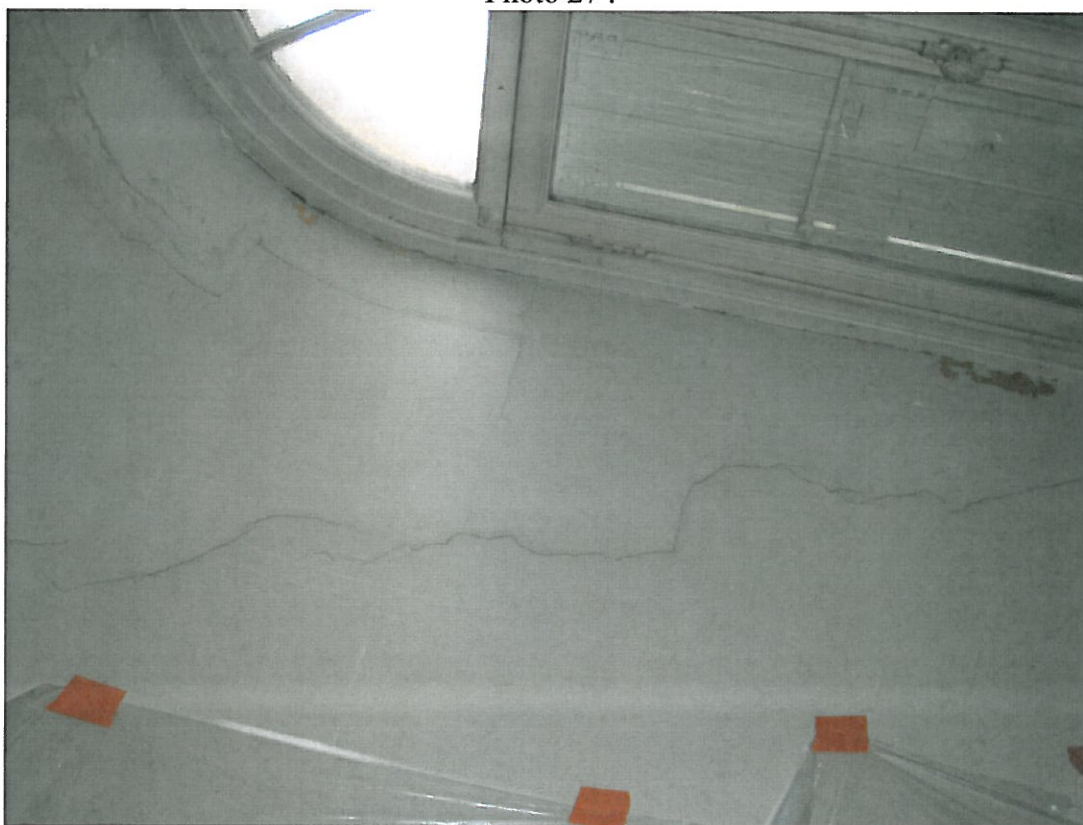
Photo 28 : fissures sur mur porteur de façade et trace de fuite d'eau ( 2 ème étage)
