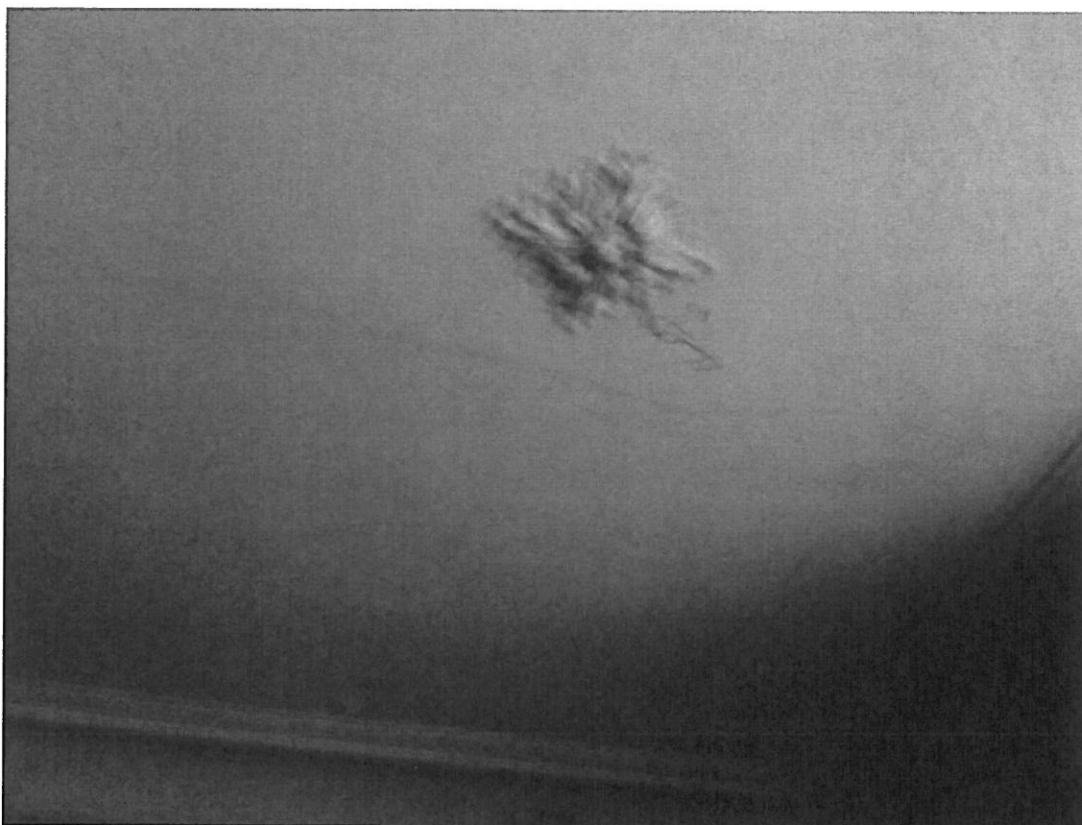
Photo 7 : fissures au niveau plancher haut dans la couche de plâtre (1 er étage)
