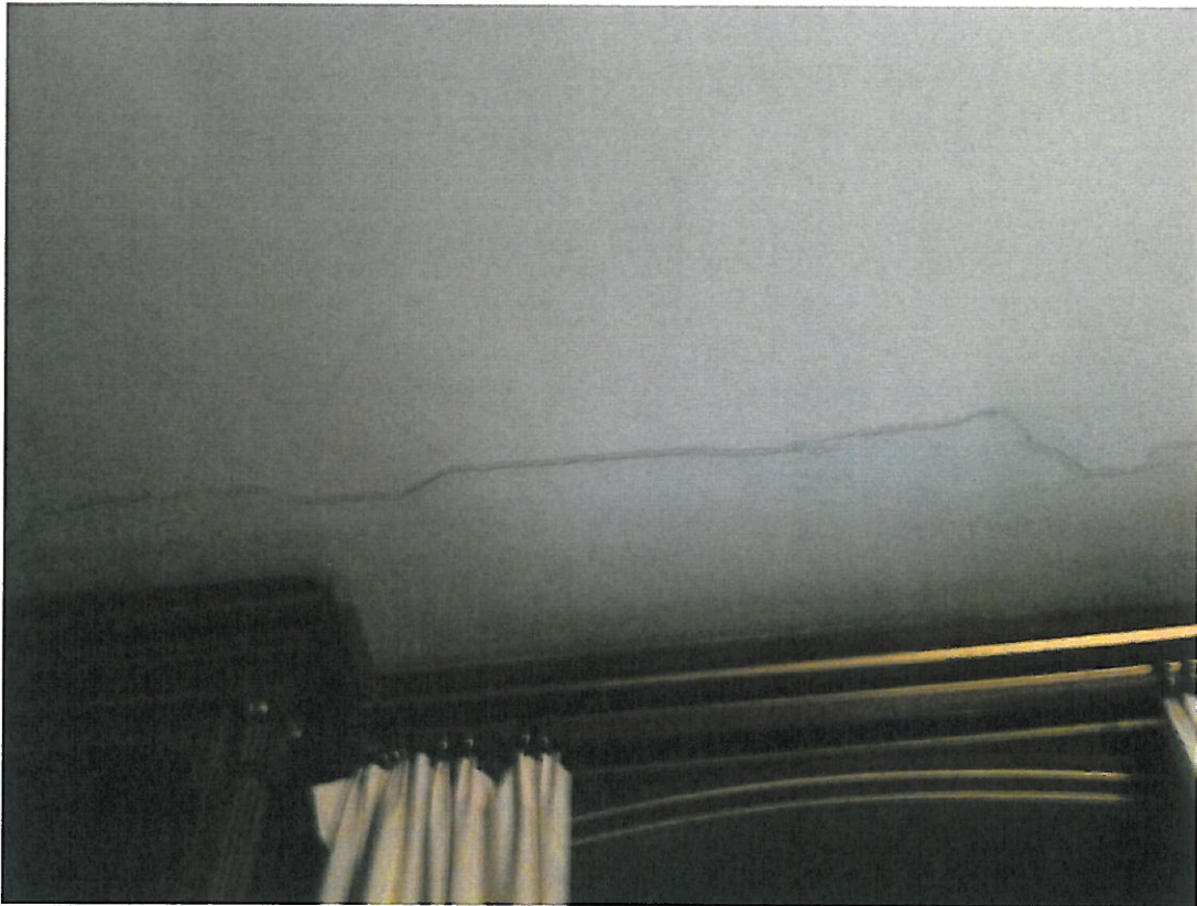
Photo 9 : fissures au niveau plancher haut dans la couche de plâtre (1 er étage)
