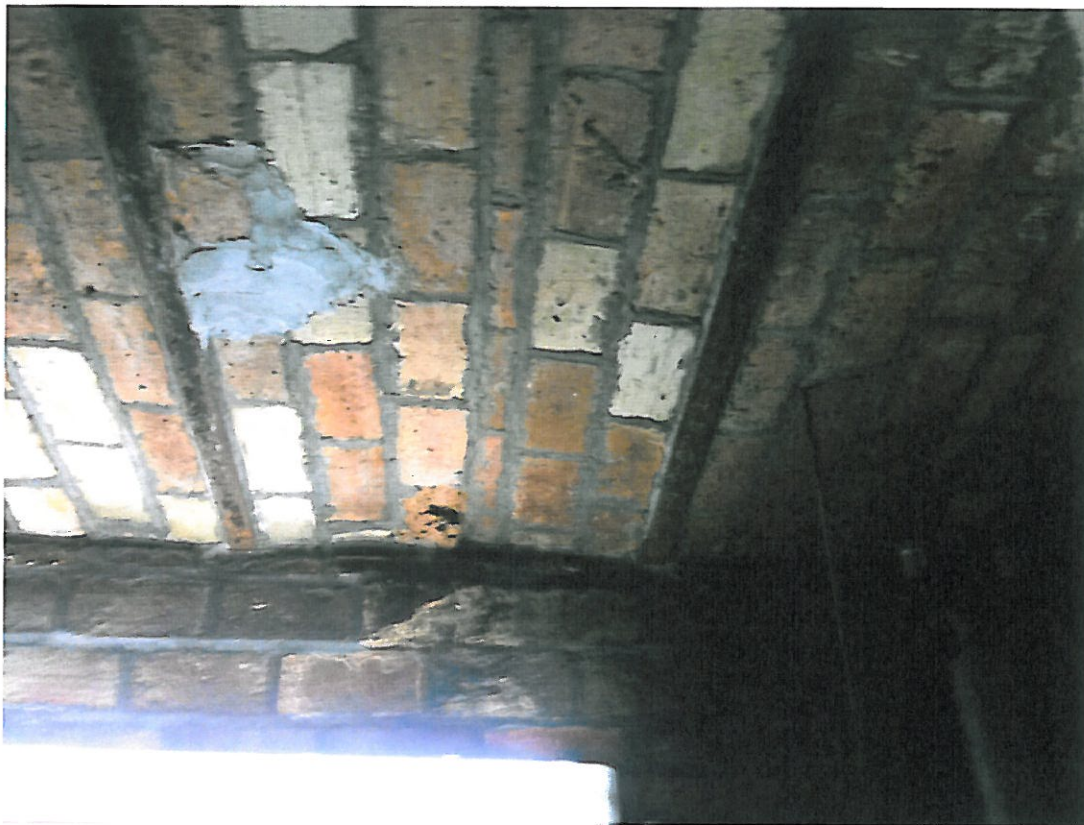
Photo 3 : profilés métalliques corrodés, briquettes en bon état (sous sol)
