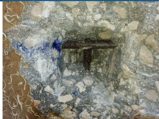
Photographie 14 : Sondage SD5 sur massif 2.4 face B, aciers sains et absence de carbonatation
