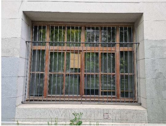
Menuiseries bois non vernis et grille en barreaudage métallique de teinte gris foncé au RDC de la façade sud.
