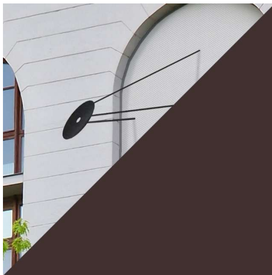
Oculus métallique sur tripode à fixer sur le panneau en carbone monolithique et teinte projetée du laquage sur l'élément.
