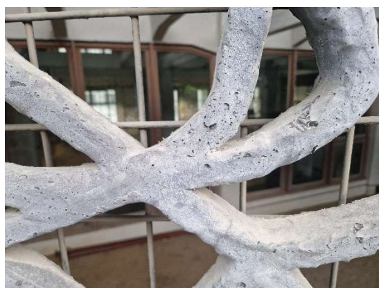
Résille en béton fibré ultra-performant (BFUP) au droit des ouvertures de la tour de l'angle sud-ouest
