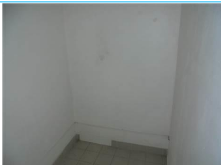
Matériaux : ZPSO-001 Prélèvement : P001; P002 Description : Enduit sur mur béton périphérique Localisation : 2 ème Etage - Rangement Résultat : Absence d'amiante
