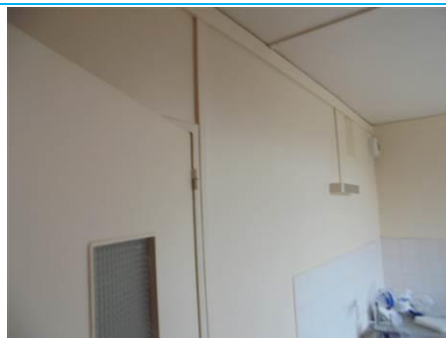
Matériaux : ZPSO-002 Prélèvement : P003; P004 Description : Enduits sur cloison plâtre Localisation : 2 ème Etage - Cuisine; 2 ème Etage - Salle de bain Résultat : Absence d'amiante
