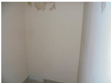
Matériaux : ZPSO-001 Prélèvement : P001; P002 Description : Enduit sur mur béton périphérique Localisation : 1er Etage - Rangement Résultat : Absence d'amiante
