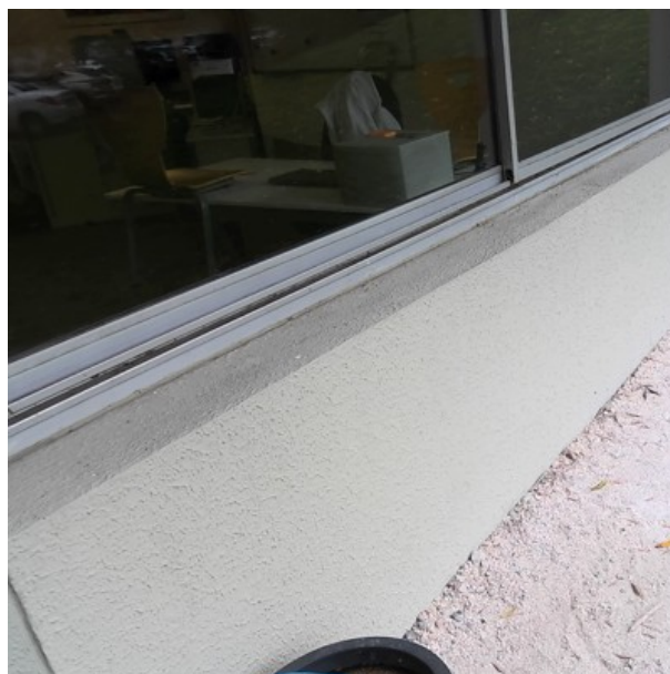
N Extérieur / Façade / Enduit projeté peinture verte [ Prélèvement n°19]
