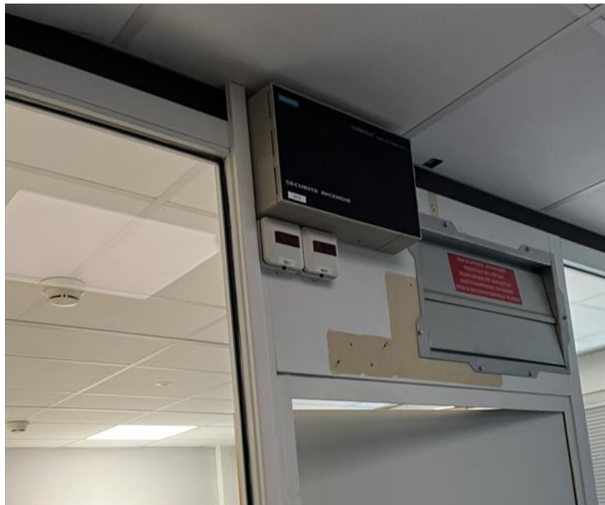
Double détection dans le local, indicateurs d'action, panneau d'évacuation et ventelle de décompression
