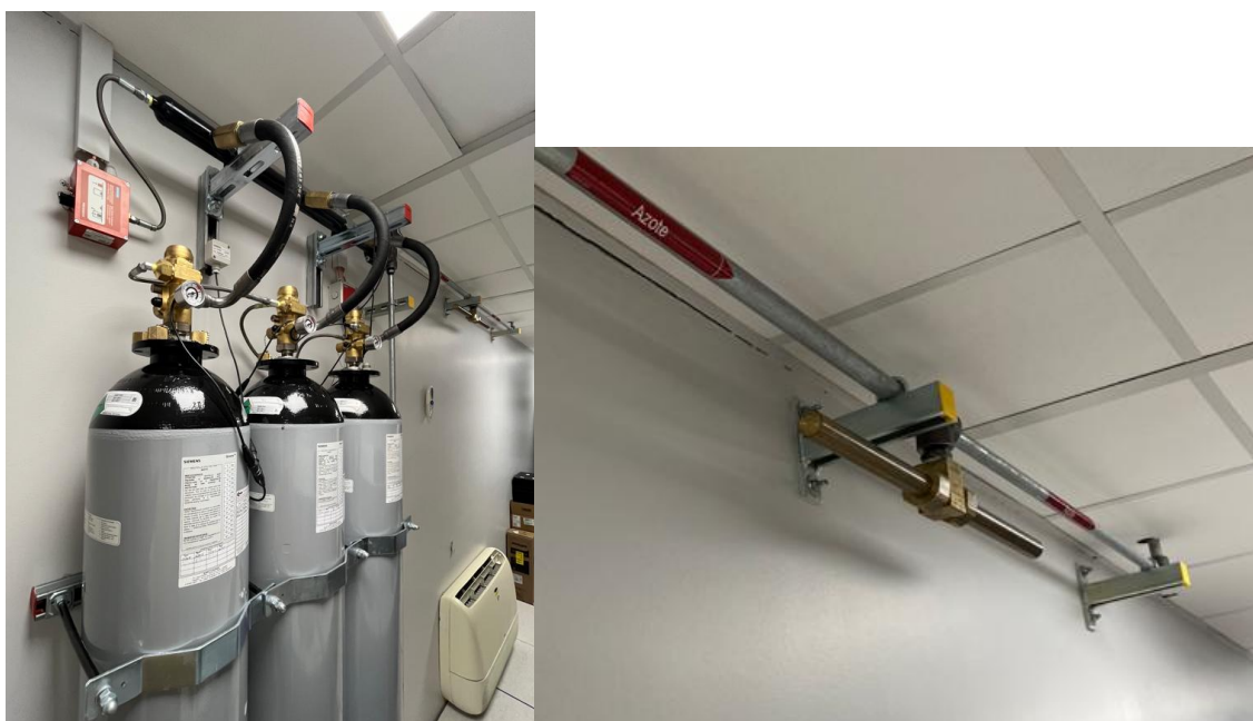
DAC de pilotage, réseau d'extinction et bouteilles
