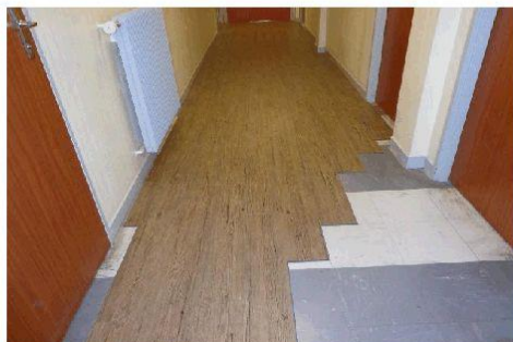
Dalle de sol plastique dalle de couleur noir et gris en Amiante confiné sous revêtement de type parquet bois repérage confrère D.E.P
