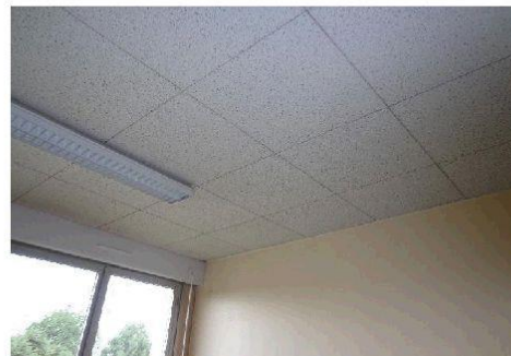
Faux plafond 60x60 non démontable de 2005
