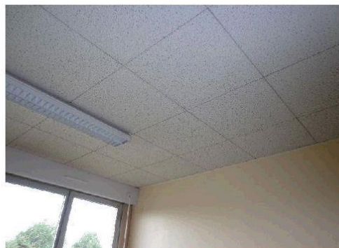
Faux plafond 60x60 non démontable de 2005
