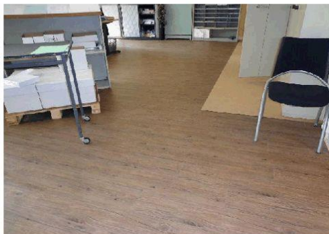
Dalle de sol plastique dalle en Amiante confiné sous un revêtement de sol de type parquet en bois repérage confère D.E.P
