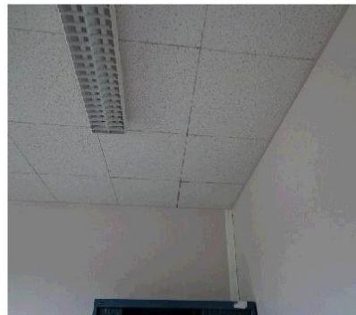
Faux plafond 60x60 non démontable de 2005
