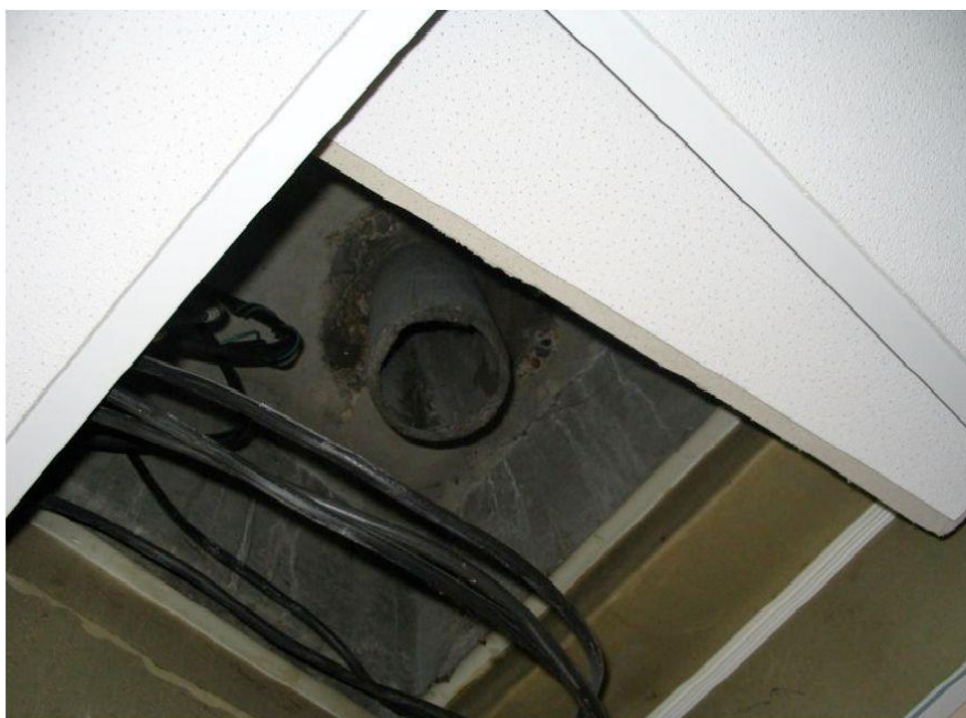
Conduit fibro-ciment n° 9 Bâtiment 37 Local imprimés au RDC
