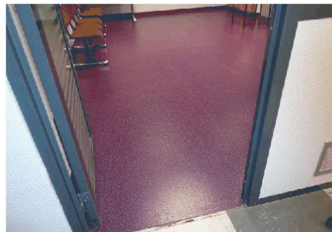
Dalle de sol plastique dalle de couleur rouge et gris en Amiante confiné sous un revêtement de type lino
