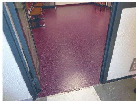
Dalle de sol plastique dalle de couleur rouge et gris en Amiante confiné sous un revêtement de type lino repérage confrère D.E.P
