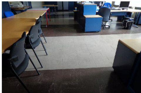
Dalle de sol plastique 30x30 de couleur marron, gris en Amiante repérage confrère D.E.P
