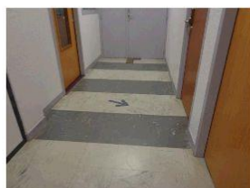
Dalle de sol plastique 30x30 de couleur gris et noir en Amiante repérage confrère D.E.P
