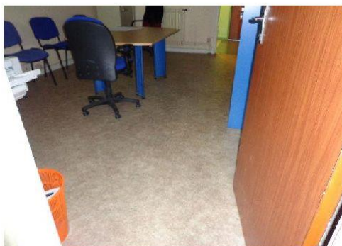
Dalle de sol plastique dalle de couleur gris et marron en Amiante confiné sous un revêtement de type lino repérage confrères D.E.P
