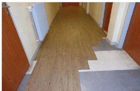
Dalle de sol plastique dalle de couleur noir et gris en Amiante confiné sous revêtement de type parquet bois
