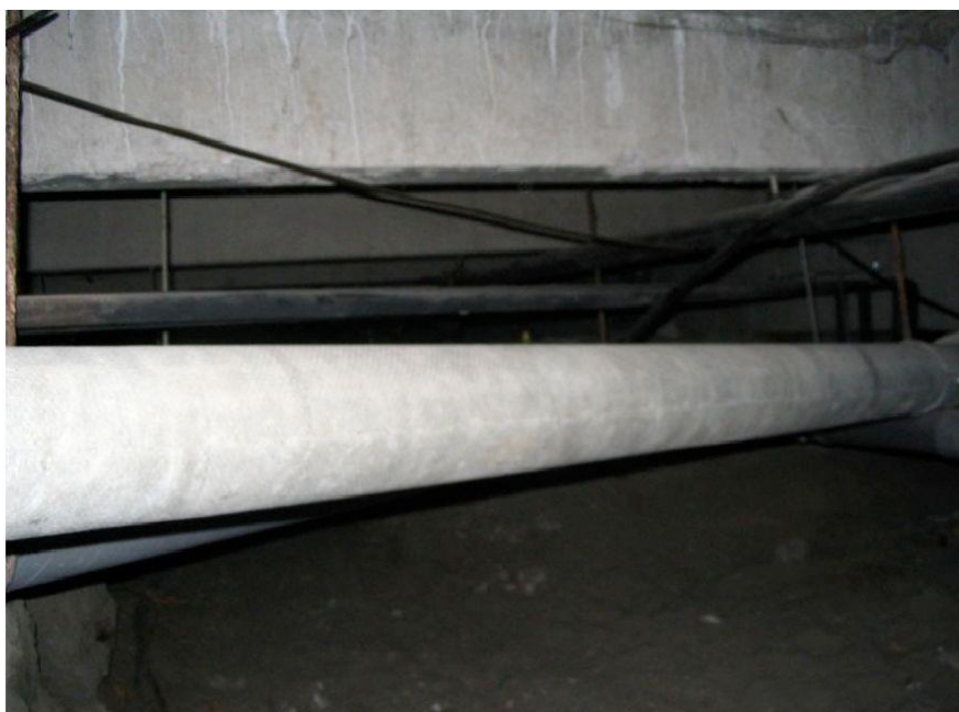
Conduit fibro-ciment n° 10 Bâtiment 37 Vide sanitaire au niveau -1
