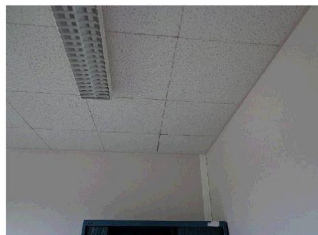
Faux plafond 60x60 non démontable de 2005
