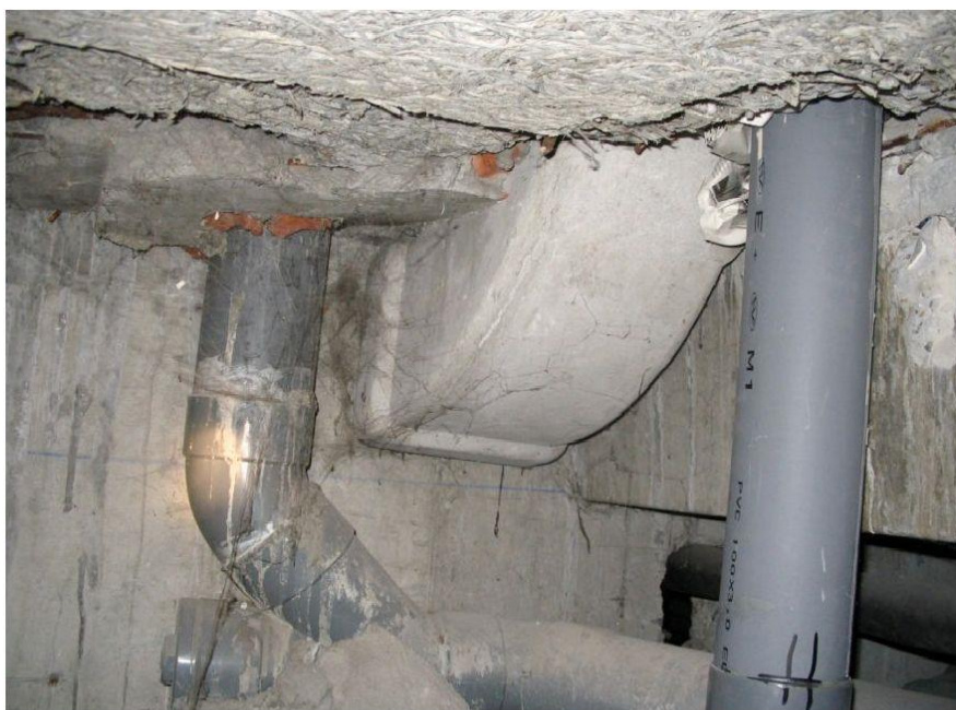
Conduit fibro-ciment n° 11 Bâtiment 37 Vide sanitaire au niveau -1
