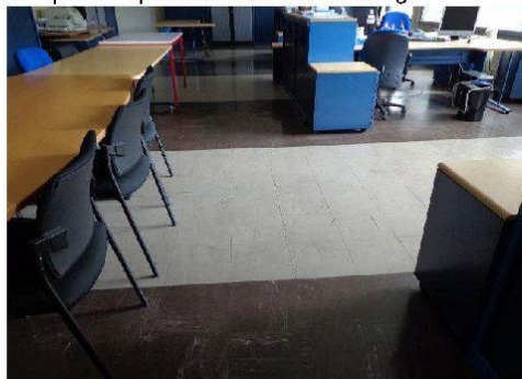
Dalle de sol plastique 30x30 de couleur marron, gris en Amiante repérage confrère D.E.P
